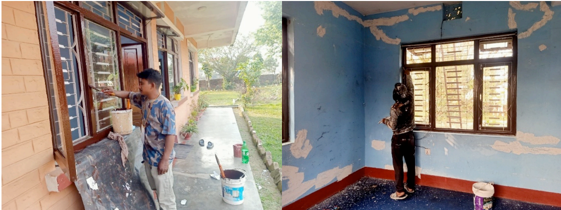
Renovierung des Rehazentrums Itahari
